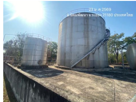
ภาพที่ 2.2-33 คั่นกันล้อมรอบ MEG Tank
