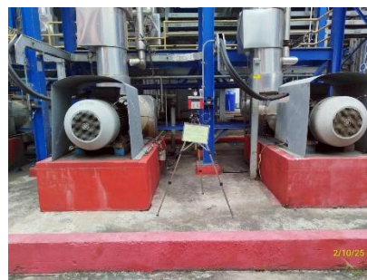
บริเวณ HTM Circulation Pump (หน่วยผลิตความร้อนที่ใช้ก๊าซธรรมชาติเป็นเชื้อเพลิง)
