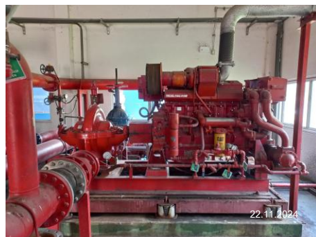
เครื่องสูบน้ำดับเพลิงแบบเครื่องยนต์ดีเซล
