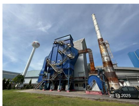
ภาพที่ 2.2-4 ระบบ ESP บริเวณปล่อง Biomass
