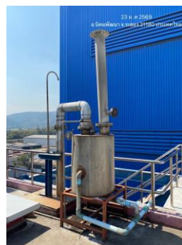
ภาพที่ 2.2-2 ระบบ Scrubber บริเวณปล่องหน่วยตั้งเตรียมสารเร่งปฏิกิริยา
